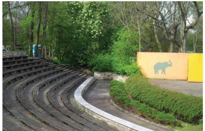
Ist-Zustand Tribüne im Tierpark
