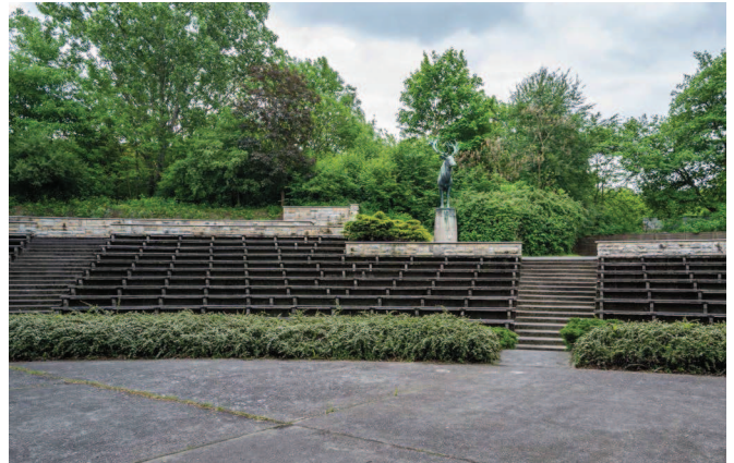
Ist-Zustand Tribüne im Tierpark
