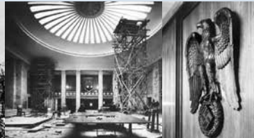
Trasformazione in "Casa degli Aviatori"
