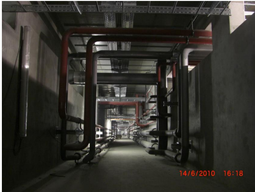
VE 5.0 Ausführungsleistungen Sanitär- Heizung-, Kälte-, Lüftungs- und Klimaanlage Fluggastterminal BBI Sanitärtrassen Medientunnel, Ebene U2
