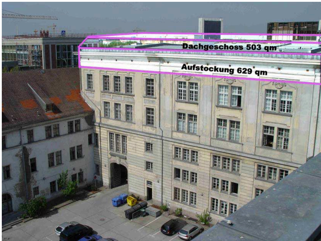
Bild 5: Aufstockung mit einem Vollgeschoss und einem ausgebauten Dachgeschoss im Haus 4
