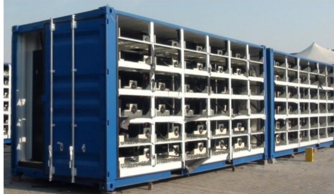
Basis- Speichersysteme für 0,7 MW / 1,4 MW (1. + 2. Stufe des Rollouts)
