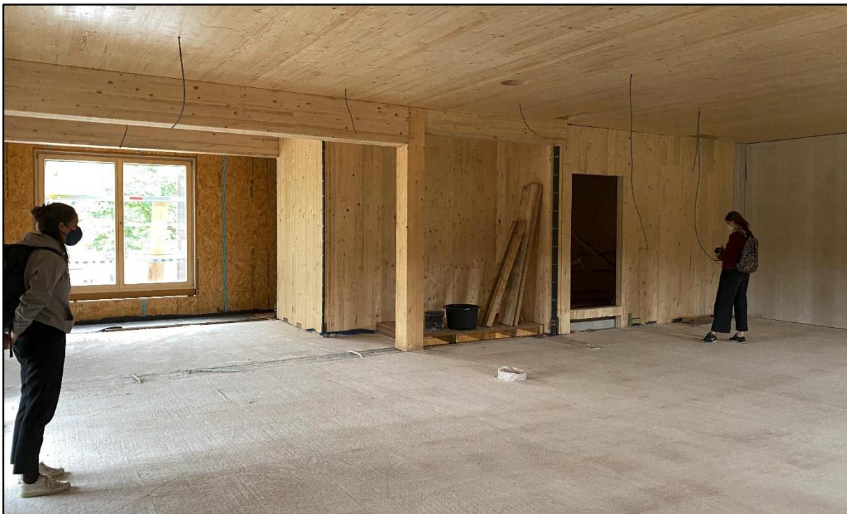
Hier sehen wir den Aufzugs- und Treppenhauskern des Gebäudes, der in Brettspernhholz errichtet ist, die Decke in Brettspernhholz, und so muss das Bauen der Zukunft sich entwickeln, um Gebäude zu CO<sub>2</sub>-Senken zu machen.
