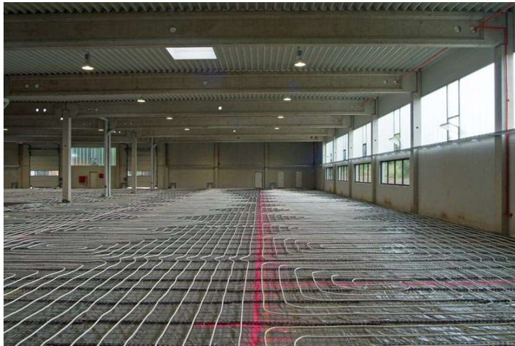
Fußbodenheizung mit Doppelboden
