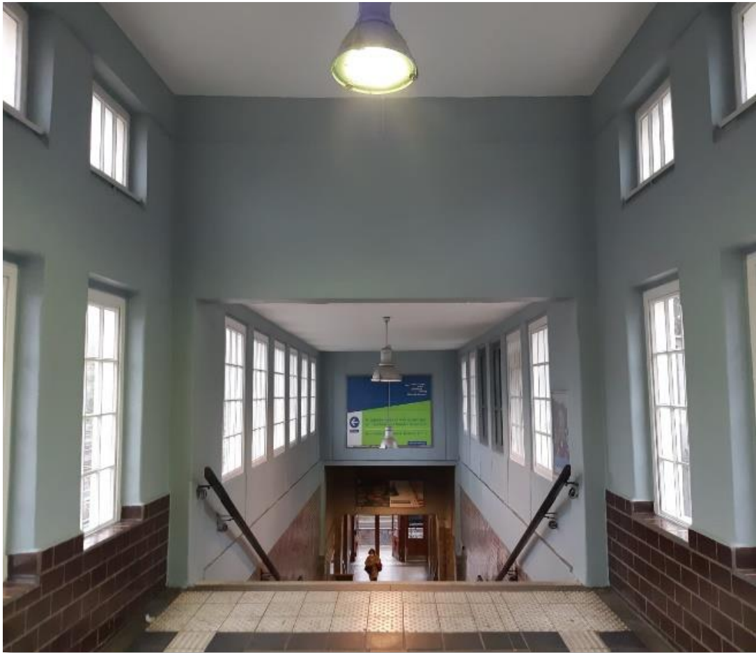
Abbildung 16: Malerarbeiten im Eingangsgebäude am S-Bahnhof Blankenburg (09/21)
