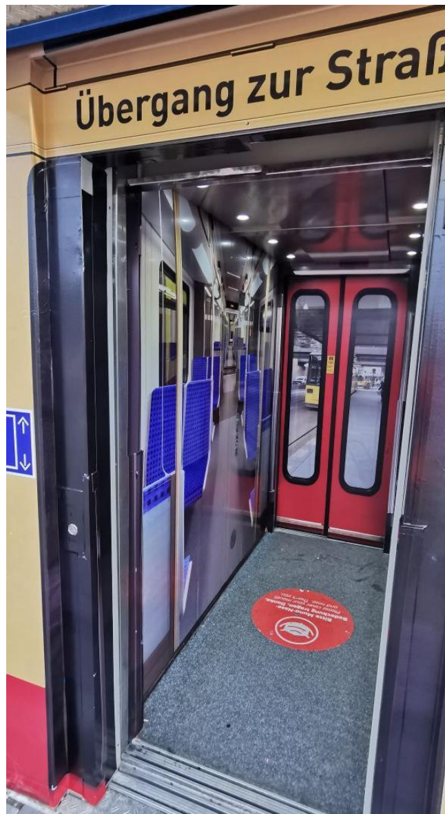
Abbildung 21: Foliengestaltung des Aufzuges am S-Bahnhof Schöneweide (10/21)
