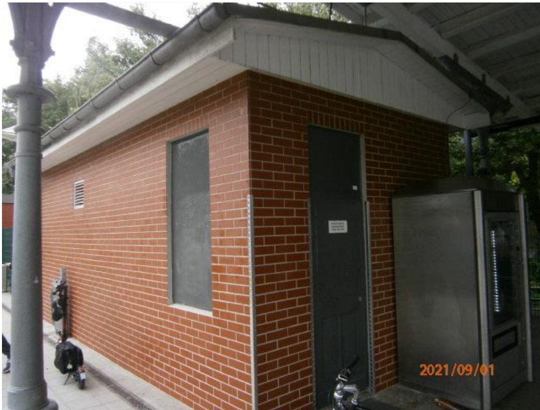
Abbildung 17: Erneuerung der Klinkerfassade der Aufsicht am S-Bahnhof Lankwitz (09/21)
