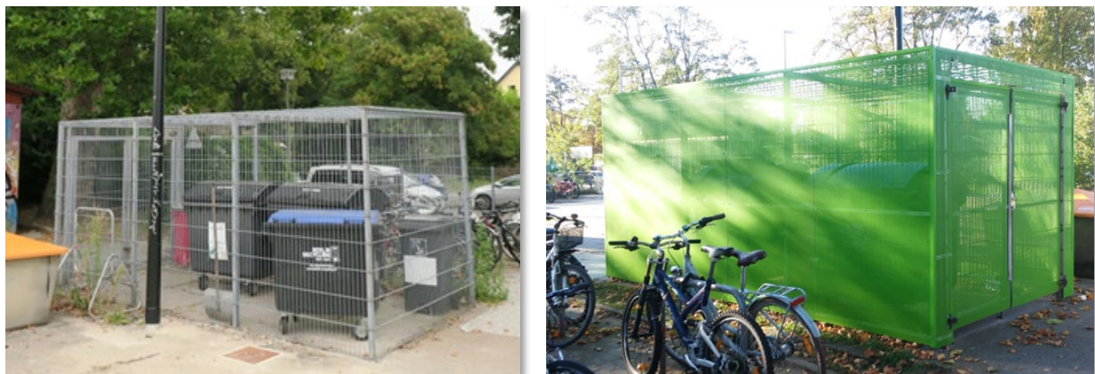
Abbildung 26: Lochblechverkleidung Mülleinhausung Bf. Spindlersfeld (vorher/nachher)
