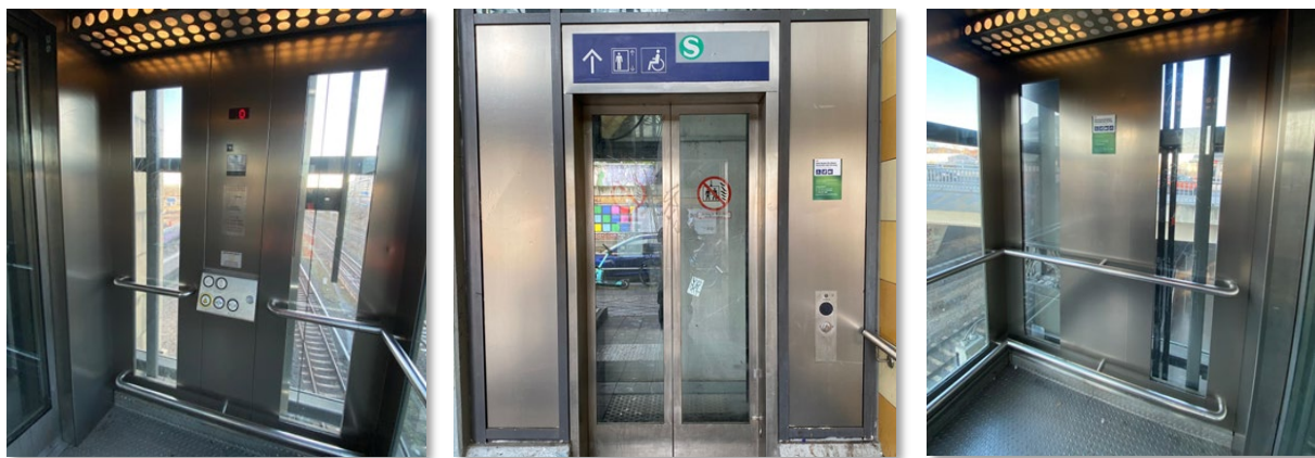
Abbildung 25b: Foliengestaltung Metallverkleidung Aufzüge (nachher)
