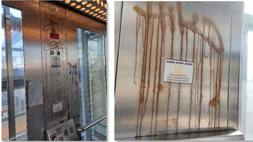
Abbildung 25a: Foliengestaltung Metallverkleidung Aufzüge (vorher)
