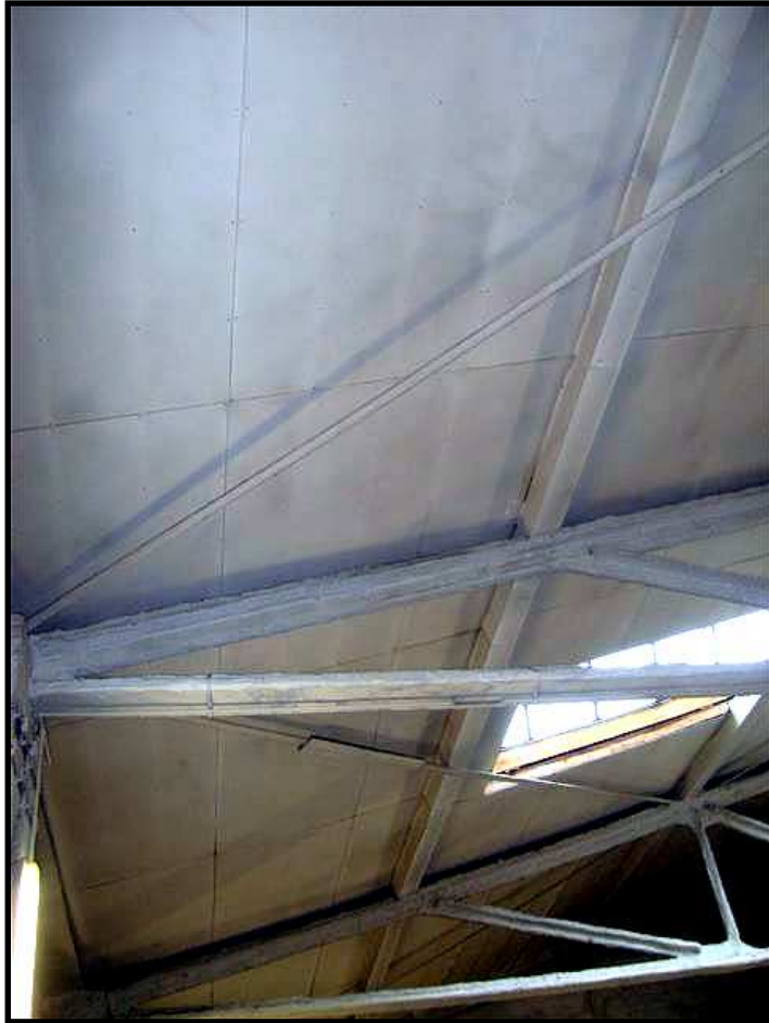
Foto 5: Deckenverkleidung aus Asbestzementplatten in der Prüfstelle in den Hallen.
