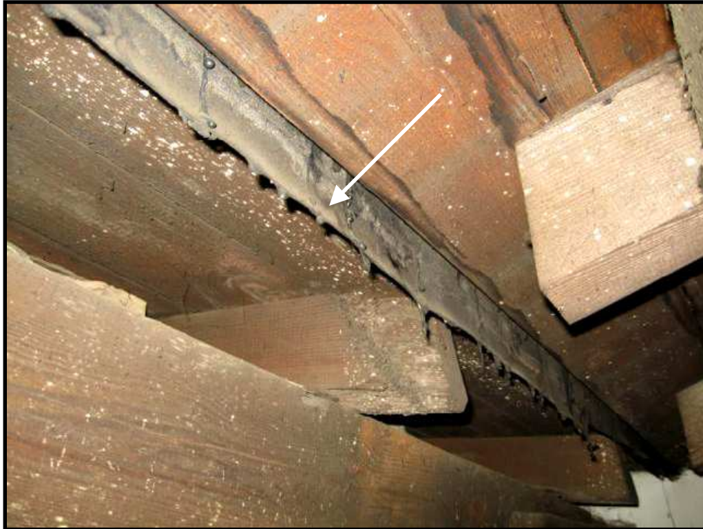
Foto 7: Stark PAK-belastete Dachpappe und Pechkleber (P 7, Pfeil) am Dachkonstruktionsholz (P 6) im Raum 109 im OG der Hallen. Infolge der Bauweise mit offenen Fugen ist der Liegestaub im Raum (P 8) ebenfalls erheblich mit PAK belastet.
