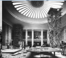
Umbau zum „Haus der Flieger“
